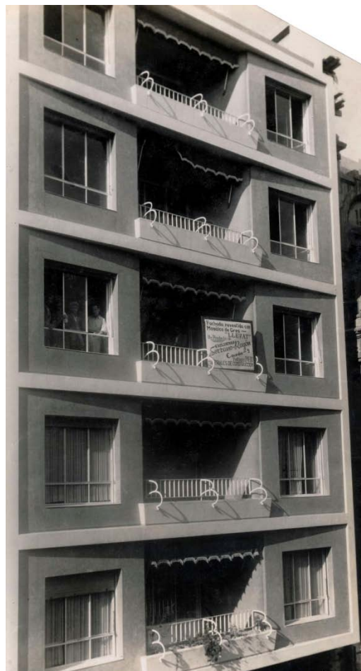
Façana de L'Hotel Principat de Oviedo
